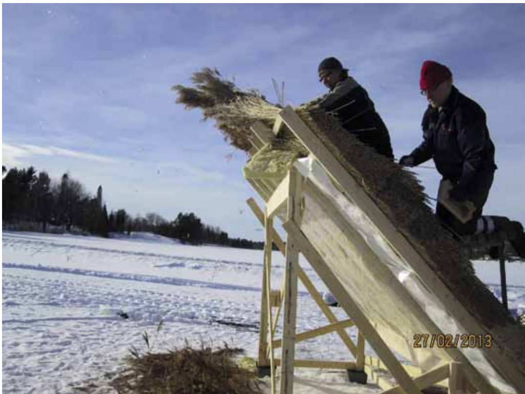
KUVA 16. Petri Iivonen tasoittamassa hammaslaudalla päätyräystä.
