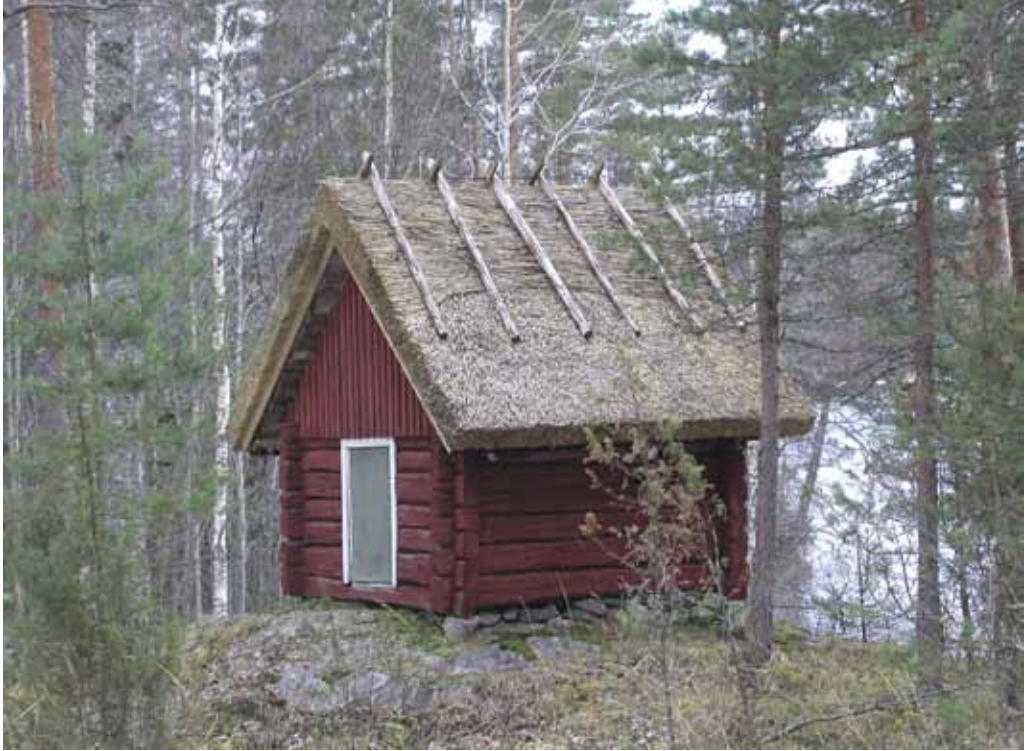
KUVA 7. Perinteisen tyylinen ruokokatto Heinolassa. Kuva: Martti Nakari.
