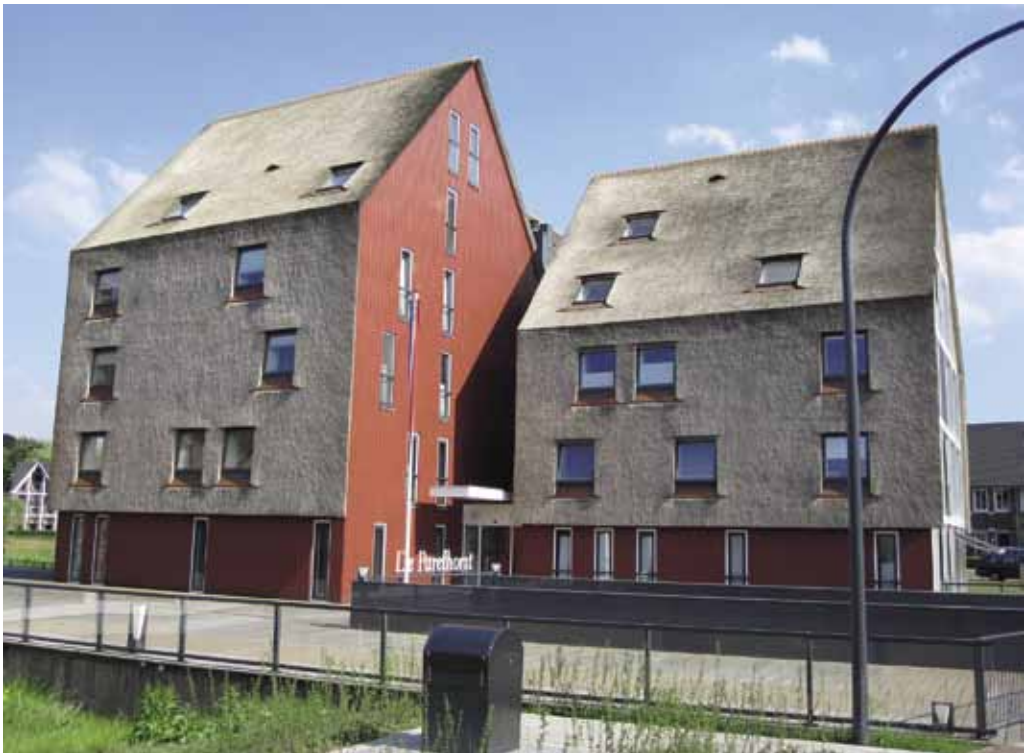
KUVA 8. Ruokoa modernisti katossa ja seinissä. Hollannissa on useita kerrostaloja ja omakotitaloja, joissa ruokoa on yhdistetty nykyaikaiseen rakentamiseen. Kuva: Rauli Lautkankare.
