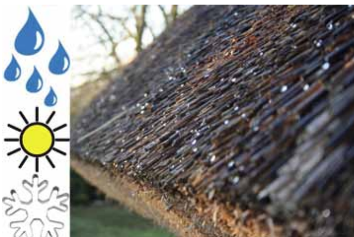
KUVA 5. Cofreen-hankkeessa selvitettiin muun muassa olosuhteiden vaikutusta ruokokattoihin. Vesi ei tunkeudu syvälle tiiviiksi tehtyyn katteeseen, sillä jokainen korsi tuo pisarat takaisin pintaan.
