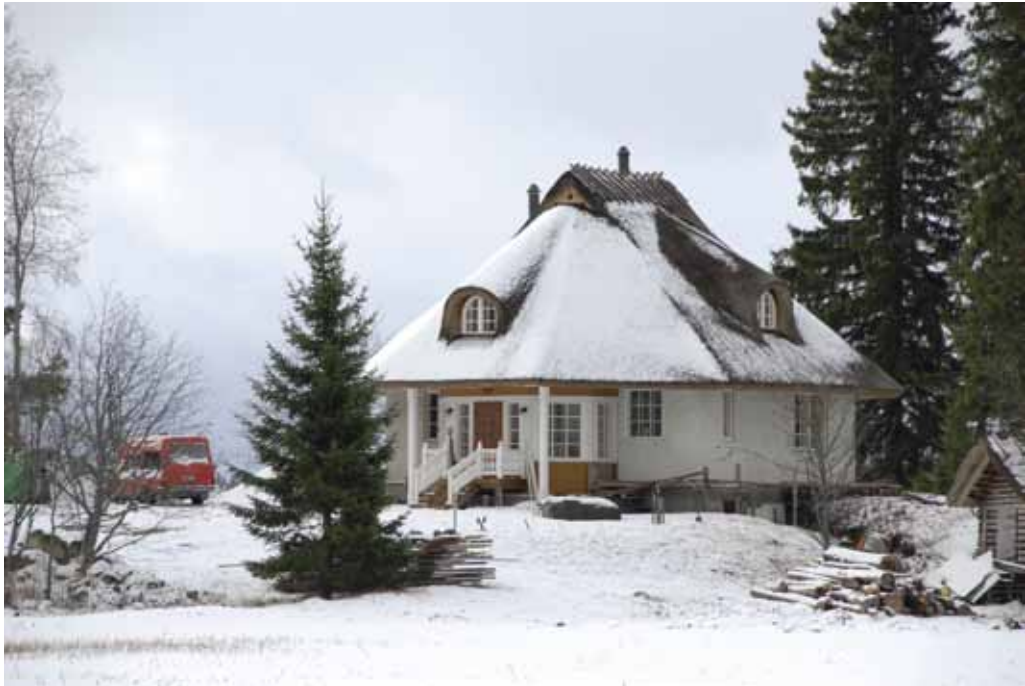
KUVA 6. Suomen vanhin ruokokatteinen asuinrakennus. Kate on asennettu vuonna 2003 ja se on huoltamattomana edelleen hyvässä kunnossa. Kuva: Juha Kääriä.
