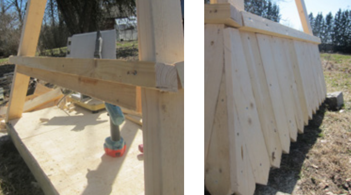
KUVA 7. ALIMMAINEN RUODE JA SEN TAAKSE PUUHELMOJA VARTEN KIINNITETTÄVÄ LAUTA. KUVA: TUOMAS ALIJOKI.
