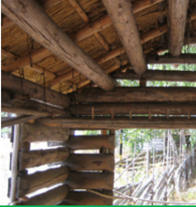
KUVA 6. ALAPUOLELTA SIDOTTUA KATTOA.
