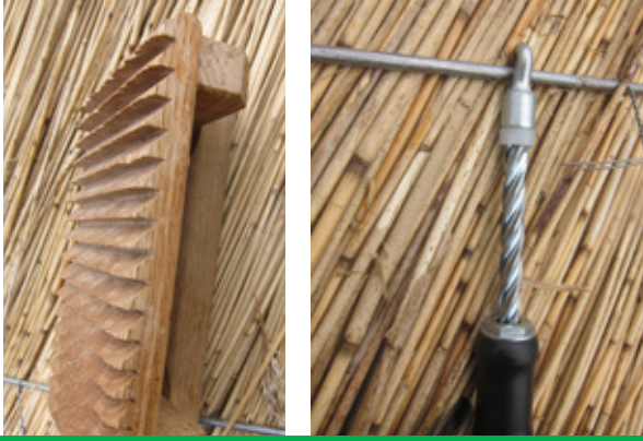
KUVA 2. KÄPPÄ ELI TASOITUSLAUTA. KUVA: TUOMAS ALIJOKEI.
