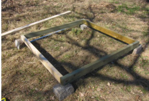
KUVA 5. TIIPIIN POHJAKEHIKKO. KUVA: TUOMAS ALIJOKI.
