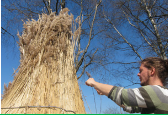
KUVA 16. HARJAN VOI SITOJA ESIMERKIKSI KESTÄVÄLLÄ LUONNONKUITUNARULLA. KUVA: SATU PAANANEN.
