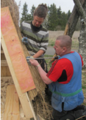
KUVA 10. RUO'ON LATOMINEN ONNISTUU HELPOITEN KAVEREIDEN KESKEN. ALOITA LATOMINEN TIIPIIN ETULAUTAA VASTEN. KUVA: SIRPA LEHTI-KOIVUNEN.
