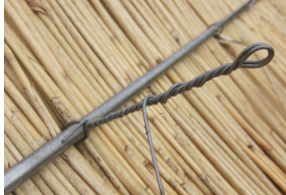
KUVA 12. HYVIN KIRISTETTY RAUTALANKA ON SIISTI. VARO KIRISTÄMÄSTÄ LIIAKSI, ETTEI RAUTALANKA MENE POIKKI, JA ETTÄ RUO'ON TASOITTELU ONNISTUU KEVYESTI. KUVA: TUOMAS ALIJOKI.
