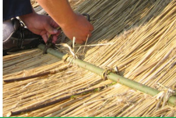
KUVA 7. PAINOPUUNA KÄYTETTY RIUKU ON SIDOTTU VITSAKSILLA.
