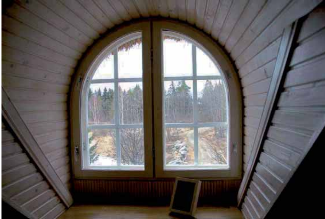
Paanasen talon yläkertaan luonnehtivat neljään ilmansuuntaan avautuvat holvimaiset ikkunat, jotka ovat syviä katon paksuuden vuoksi. Valokuva: Juha Kääriä
