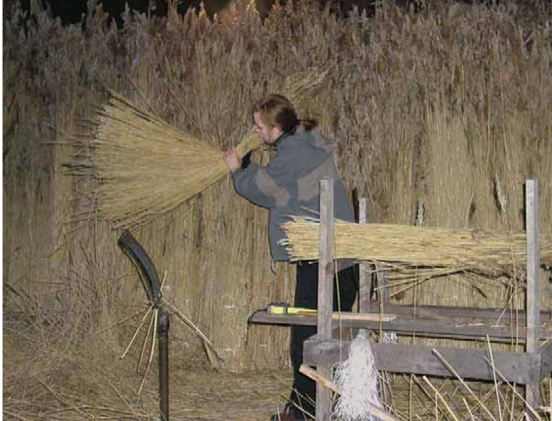
Ruo'on puhdistus ja varastointi.
