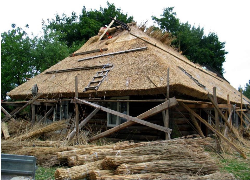
Kuva 3. Rakenteilla oleva ruokokatto Virossa Muhun saarella. Kuva: Henna Silén.
